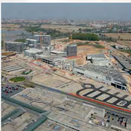
Opere di urbanizzazione primaria del Complesso Polifunzionale di Assago Multipurpose complex in Assago works for the provision services
