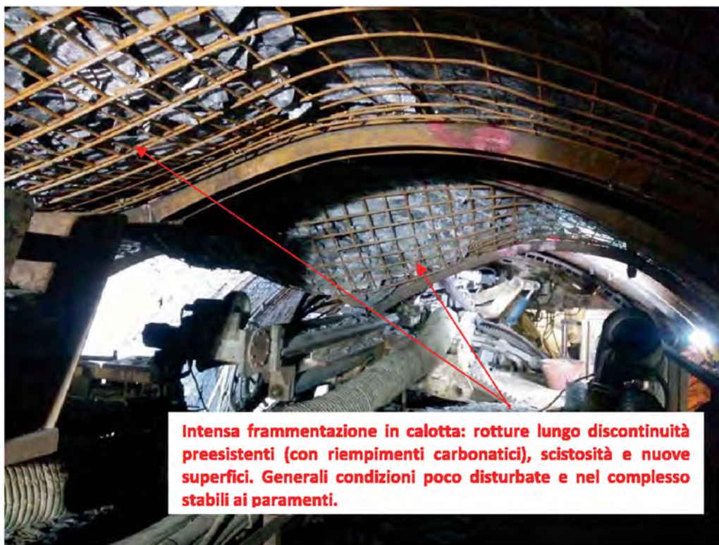
Figura 10 – Evento di rottura verificatosi alla pk 4+200 circa del Cunicolo geognostico della Maddalena.
