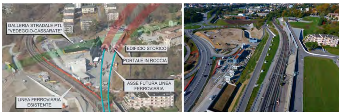
Figura 11. Vista di insieme del Portale di Vezia nelle fasi esecutive (a sinistra) e nella fase finale (a destra)
