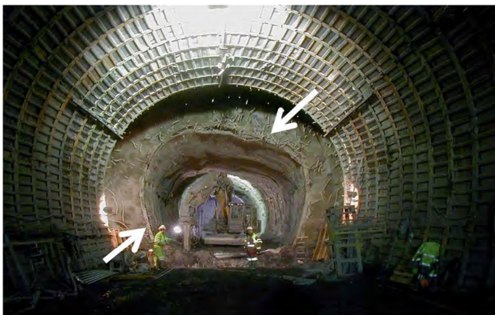
Figura 1 – Problemi delle convergenze incontrate nella discenderia SMP
