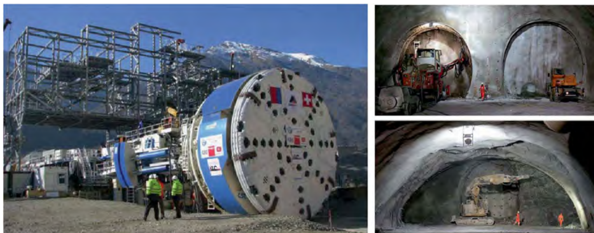
Figura 5. Gripper TBM per lo scavo della finestra di Sigirino e fasi di scavo delle caverne di Sarè
