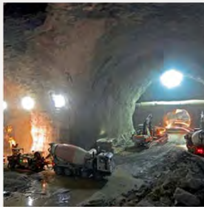
Galleria di Base del Brennero Brenner Base Tunnel
