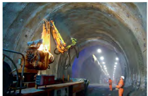
Figura 8. Profilo tipo di sostegno SPV10 con centine deformabili adottato nell'attraversamento della Val Colla (a sinistra) e deformazioni monitorate durante gli avanzamenti della GbC-Ovest a nord della CAOP.
