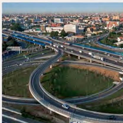
Tangenziale Est Milano Ristrutturazione dello svincolo di Lambrate Milan East ring road - Restoration of Lambrate junction
