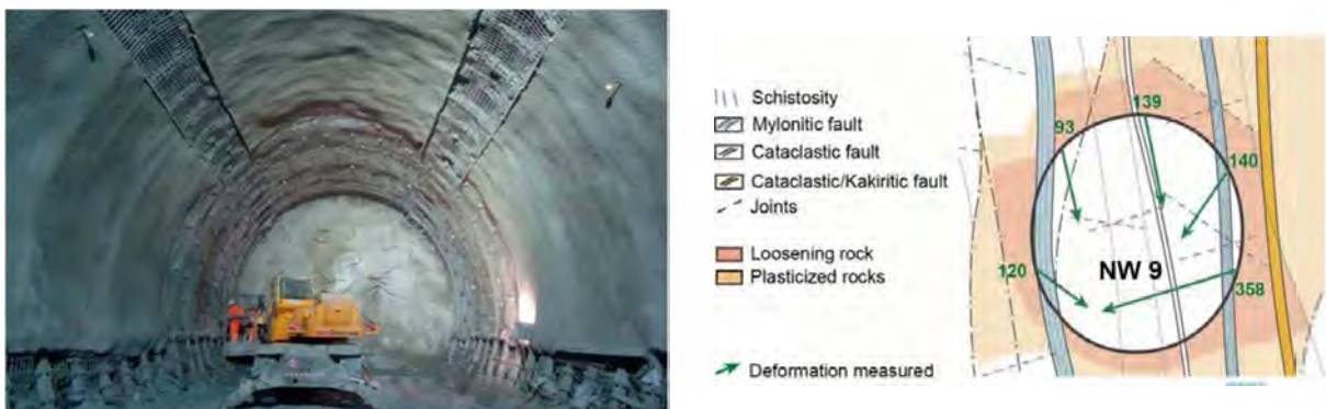
Figura 8. Profilo tipo di sostegno SPV10 con centine deformabili adottato nell'attraversamento della Val Colla (a sinistra) e deformazioni monitorate durante gli avanzamenti della GbC-Ovest a nord della CAOP.
