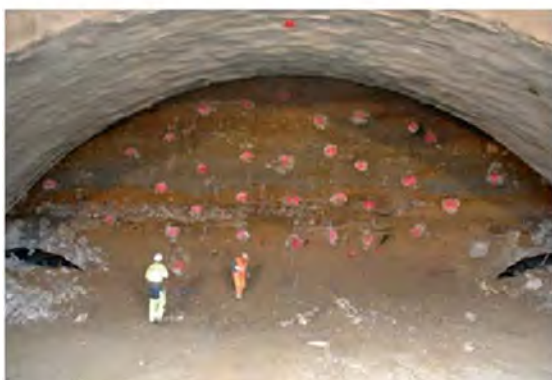
Figura 10. Controavanzamento al portale nord nella tratta del sottoattraversamento dell'autostrada N2 e vista del portale nord al termine dei lavori
