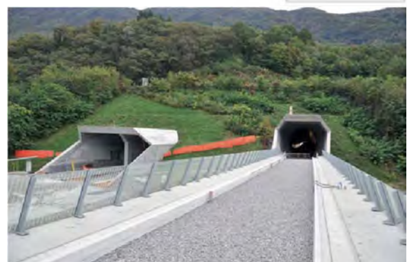
Figura 10. Controavanzamento al portale nord nella tratta del sottoattraversamento dell'autostrada N2 e vista del portale nord al termine dei lavori
