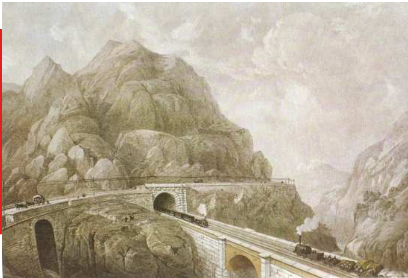
Una veduta della ferrovia Torino- Genova nei sui primi anni di esercizio: nel disegno di Carlo Bossoli è ritratta la galleria di Pietra Bissara. Immagine tratta da Diego Vaschetto «Treni e ferrovie del Piemonte».
