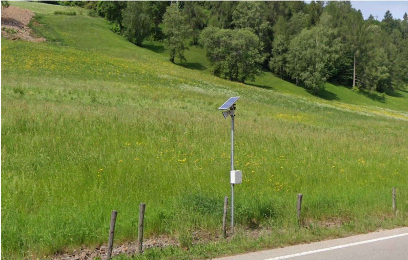
Località Pausa (bassa Atesina – Bolzano) – tratto sperimentale 500m
