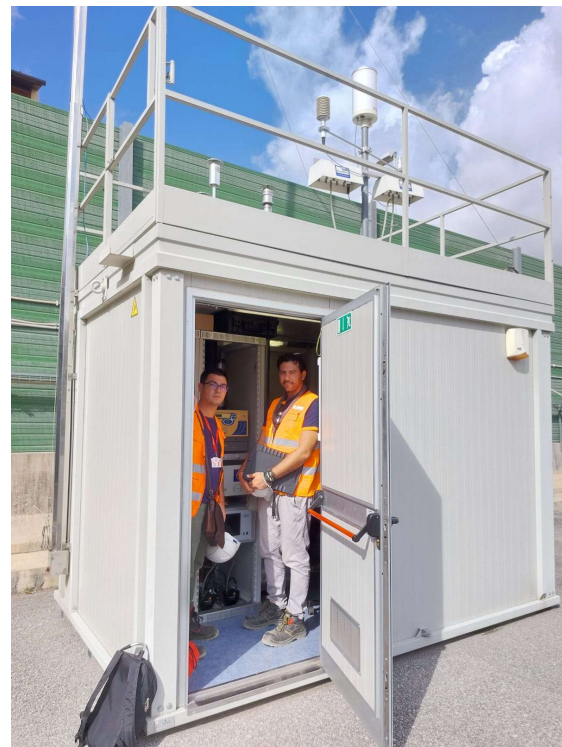
Monitoraggio Atmosfera Stazione AV
