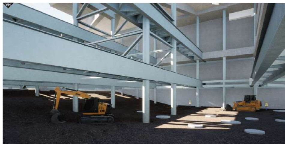
VISTA 04 Approfondimento dello scavo da quota +30.00m a quota +23.40 nelle testate Sud della Stazione
