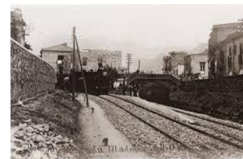
Treno proveniente da Lollì in prossimità del bivio Madonna dell'Orto; il binario affiancato appartiene all'originaria linea per il Porto.
