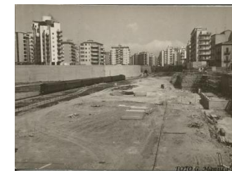
Fase della costruzione della stazione Palermo Notarbartolo . (foto Giuseppe Maniscalco)
